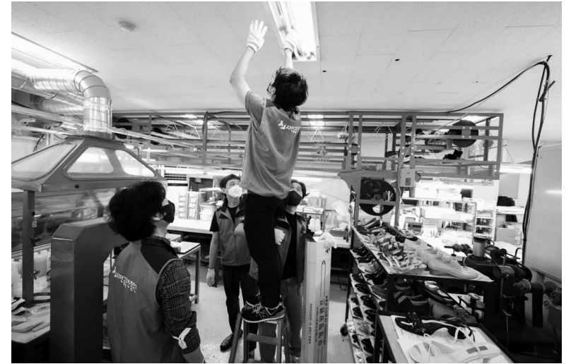
사무금융우분투재단_서민금융진흥원지부 제화사업장 노후 LED조명 교체 사회연대 활동
